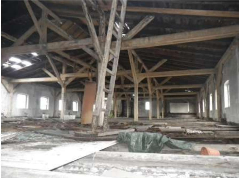
Abbildung 25: Einsturzgefährdeter Dachboden des Gebäudes 5
