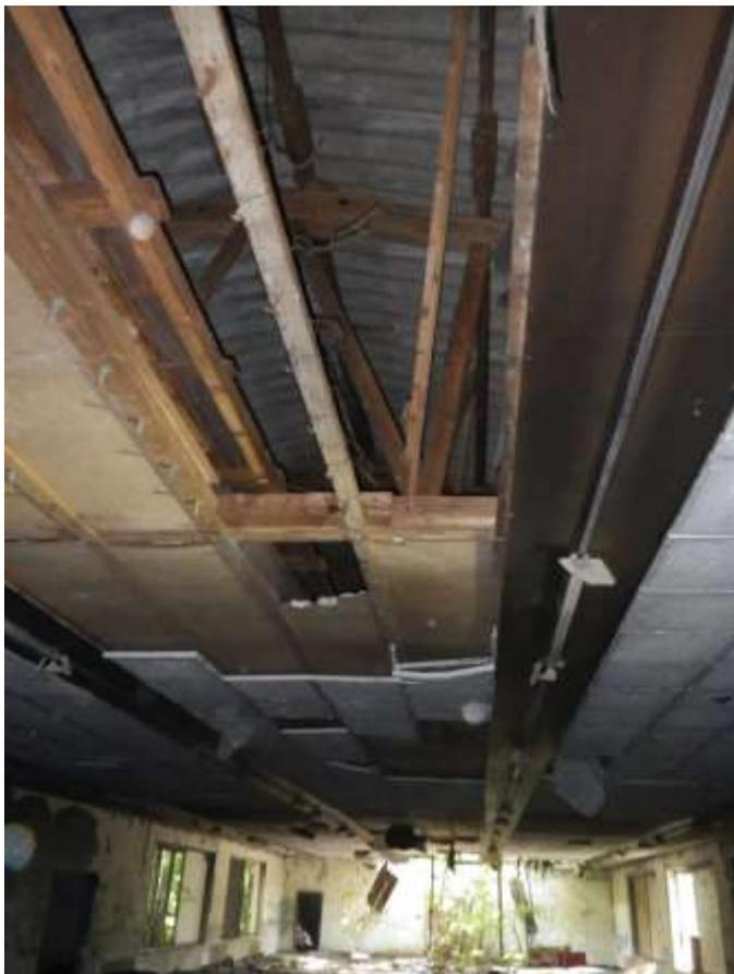
**Abbildung 4: Teilweise offene Dachkonstruktion**
