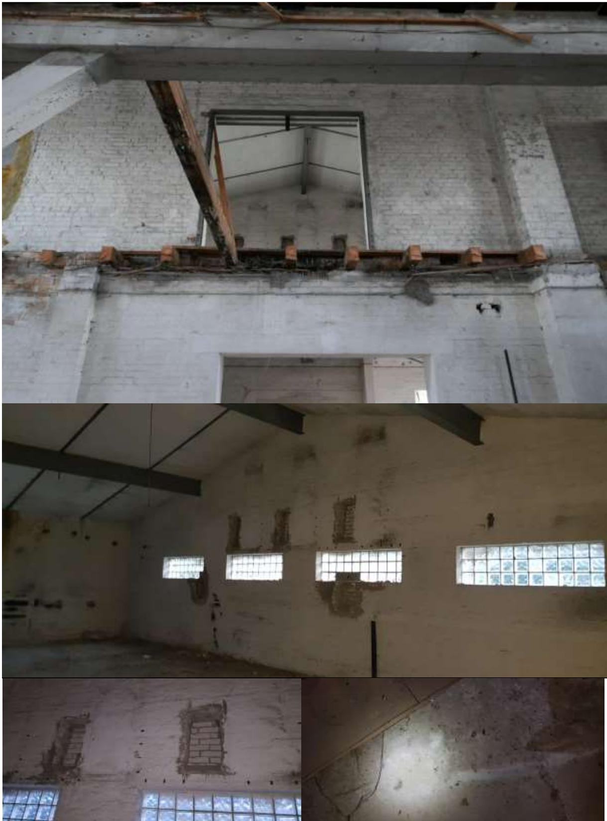
Abbildung 16 Betondachstuhl von Gebäude 3 (Westseite)
