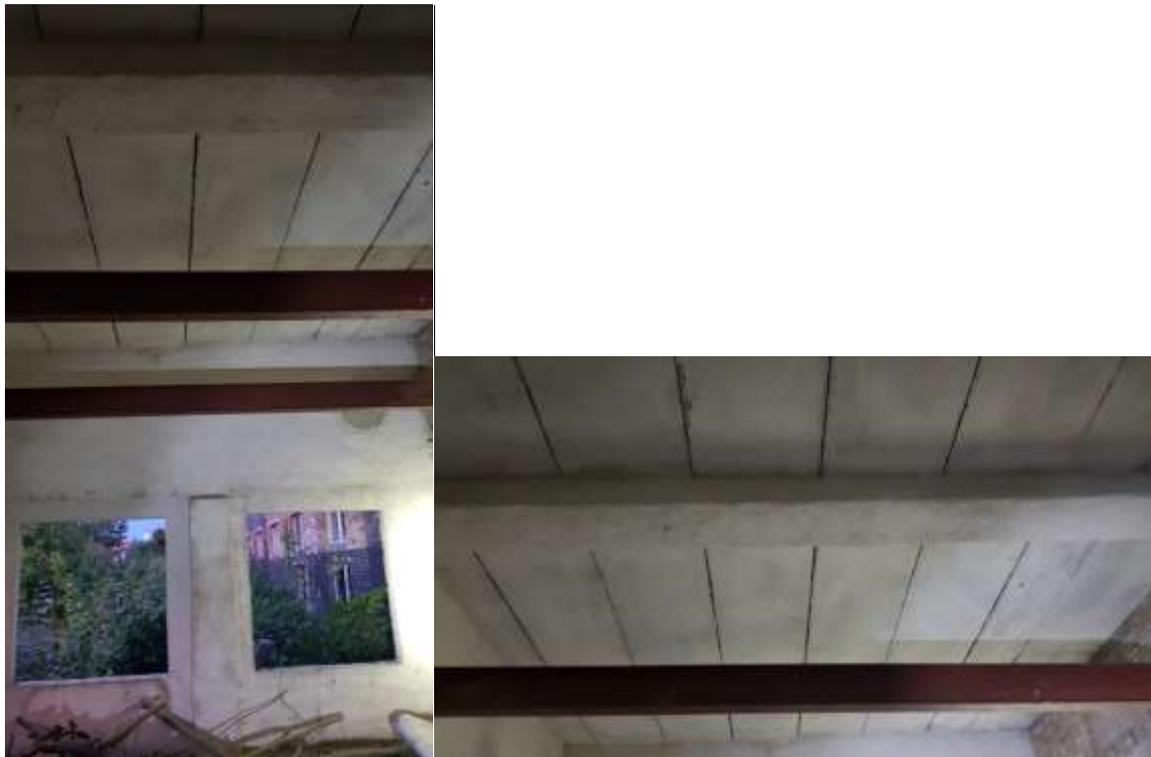
Abbildung 10 Spaltenstrukturen in Deckenelementen des östlichen Bereichs von Gebäude 2
