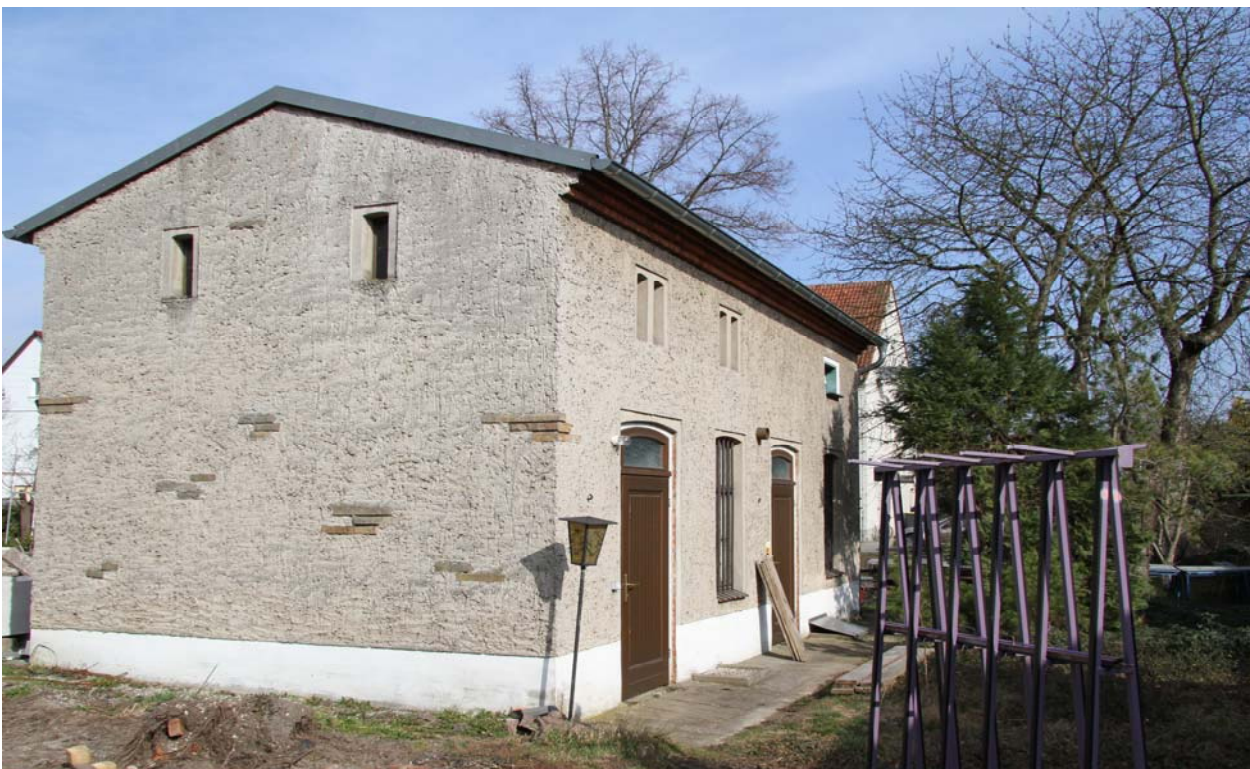
Abb. 8: Außenansicht vom ehemaligen Taubenschlag
