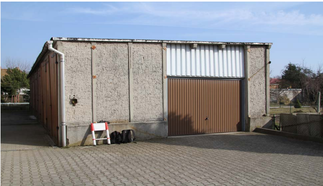
Abb. 5: Westseite des Garagenkomplexes mit nachträglich eingebautem Garagentor
