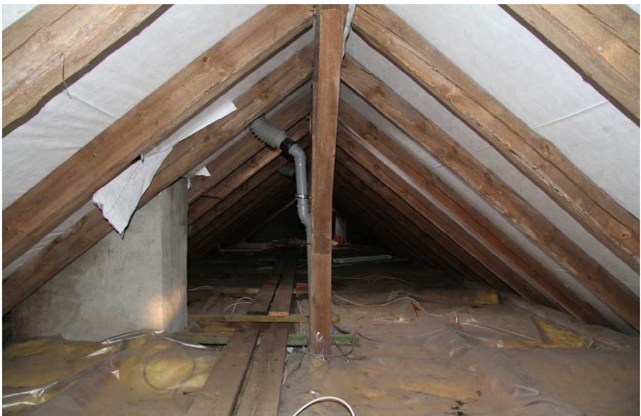
Abb. 1: Spitzboden mit Unterspannbahn und Dachbodenisolierung
