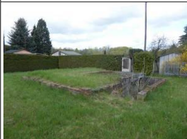
Foto 3: Fundament einer ehemaligen Bebauung mit noch existentem Kellerraum (Foto: Wiesner, 18.4.16)
