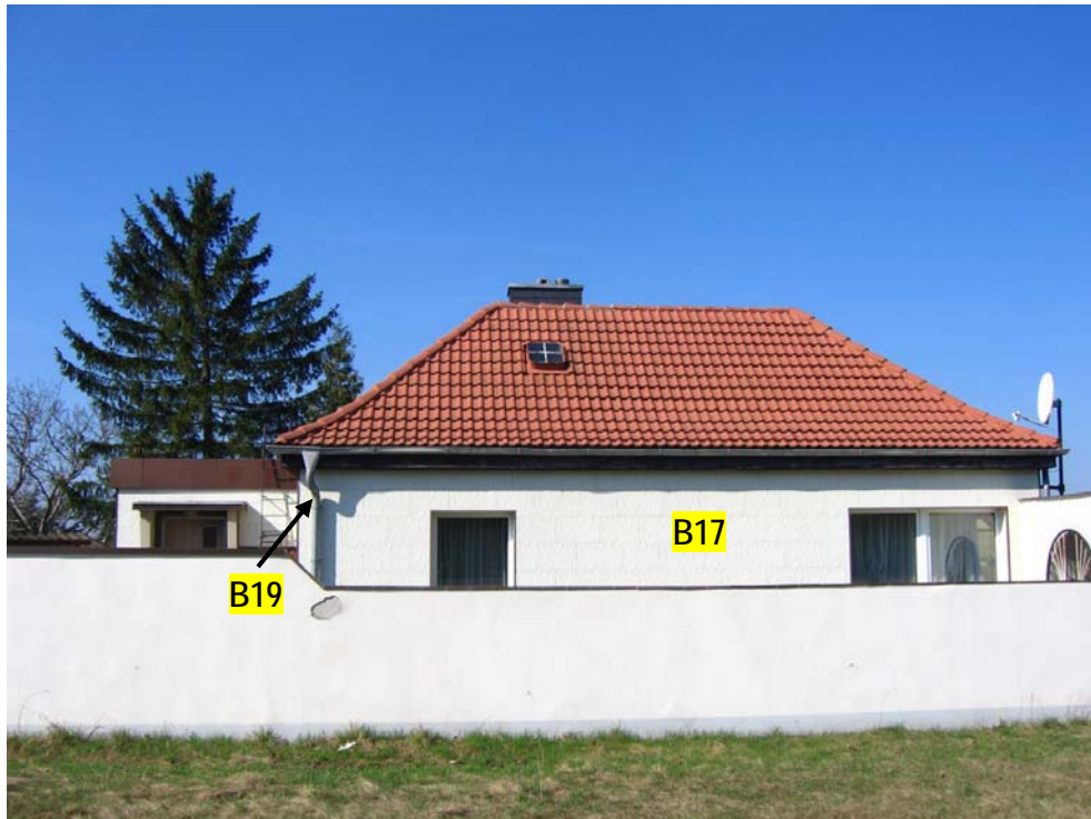
Foto 9 Wohngebäude Margaretenstraße 88, Ost-/Südfassade Berechnungsprofil B17, B19
