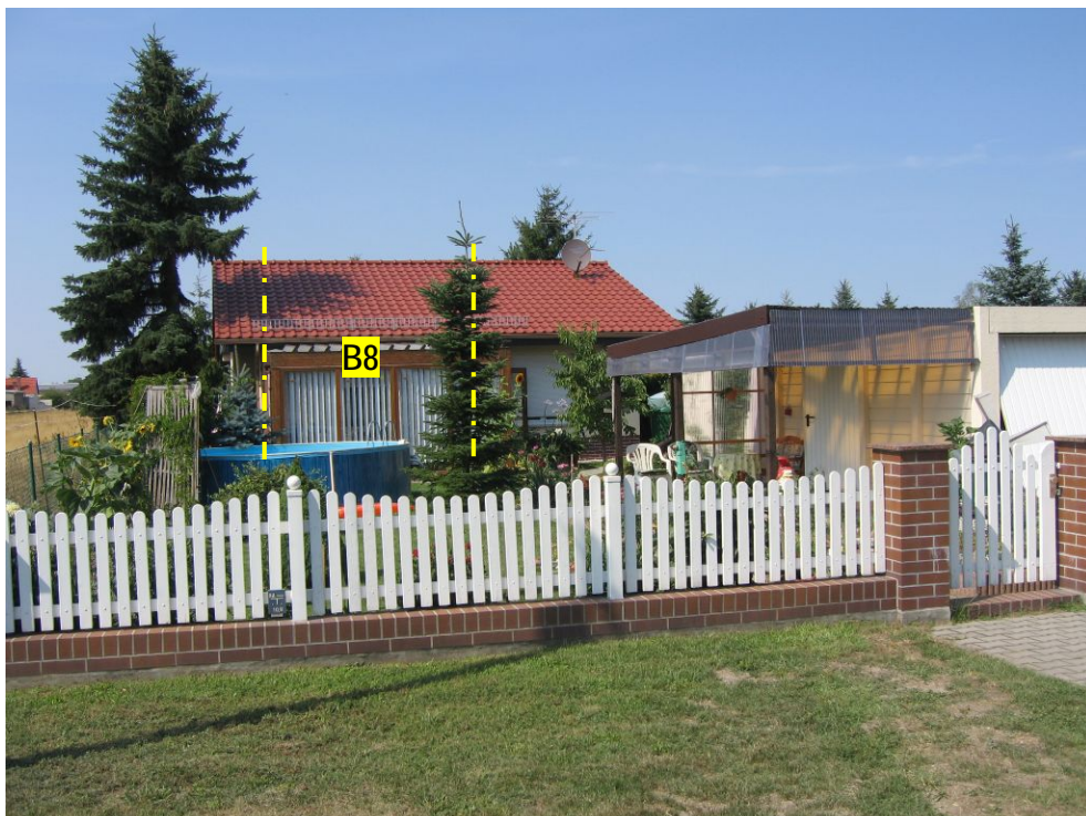
Foto 6 Wohngebäude Klarastraße 93, Südfassade Berechnungsprofil B8
