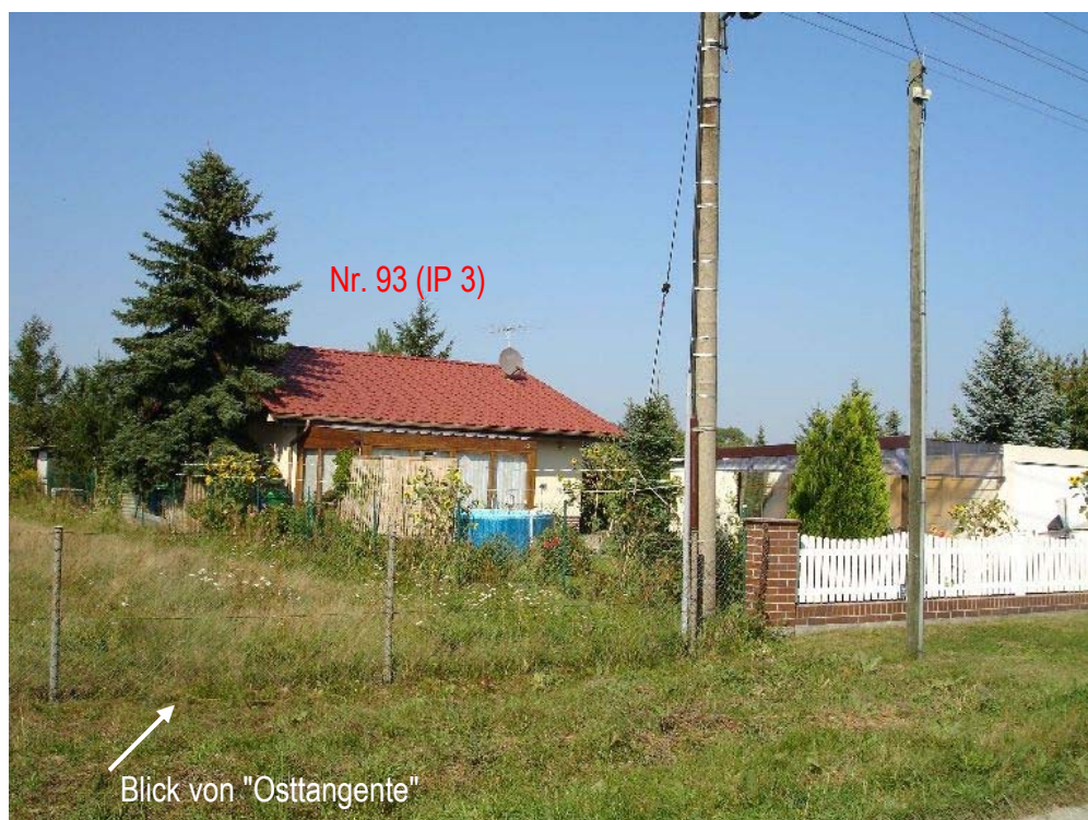
Bild 6 Wohnhaus Klarastraße Nr. 93, IP 3
