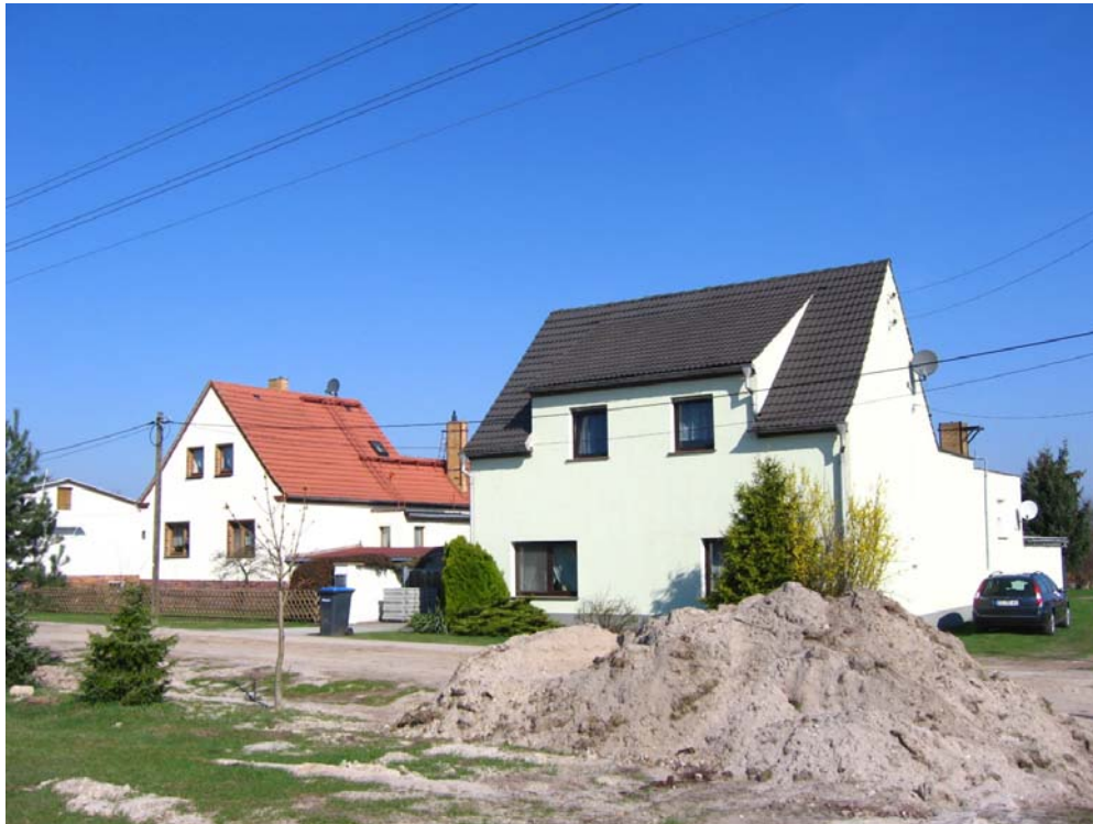
Bild 13 Wohngebäude Helenenstraße Nr. 49, IP 20
