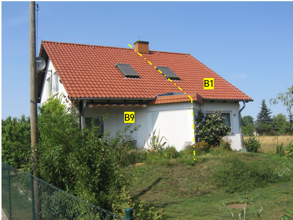
Foto 1 Wohngebäude Klarastraße 87, Südfassade Berechnungsprofil B1, B9
