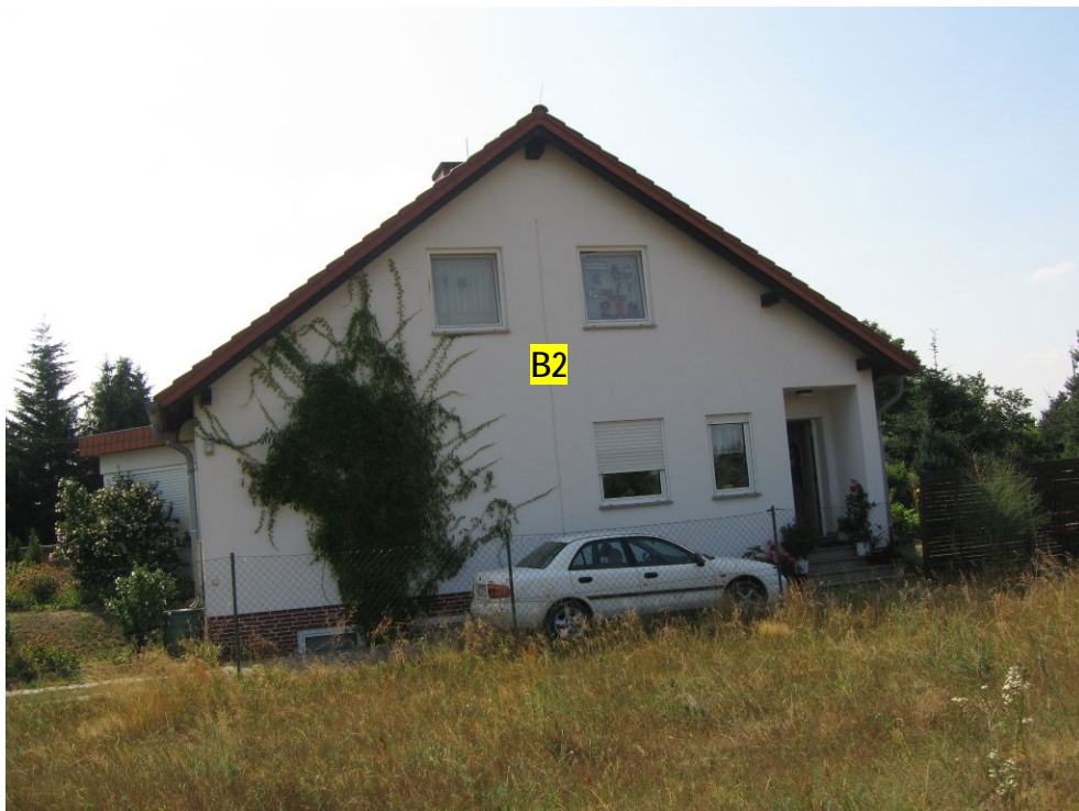
Foto 2 Wohngebäude Klarastraße 87, Ostfassade Berechnungsprofil B2
