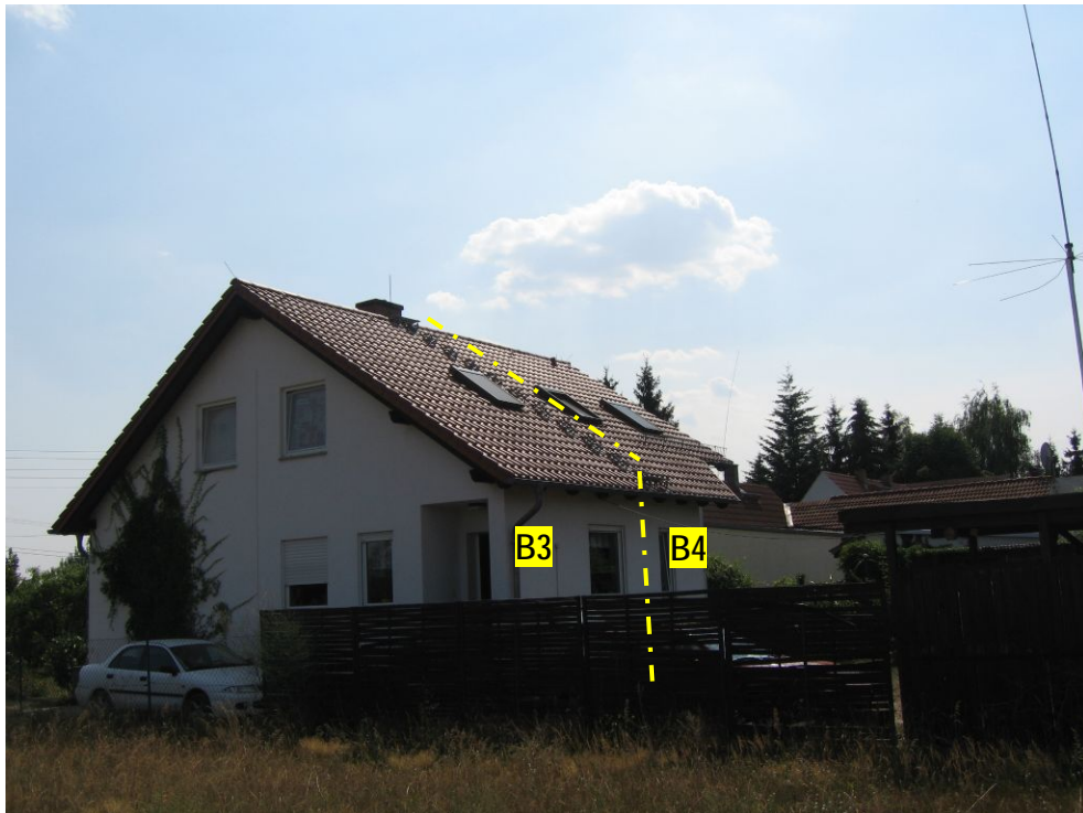
Foto 3 Wohngebäude Klarastraße 87, Nordfassade Berechnungsprofil B3, B4
