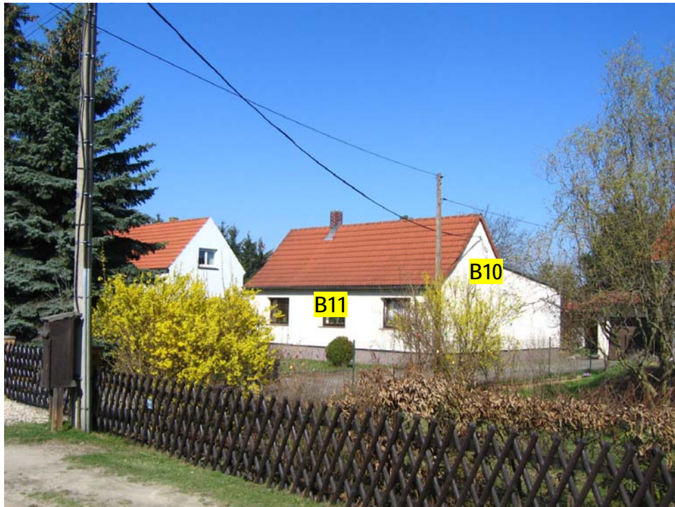
Foto 7 Wohngebäude Klarastraße 85, Süd-/Ostfassade Berechnungsprofil B10, B11
