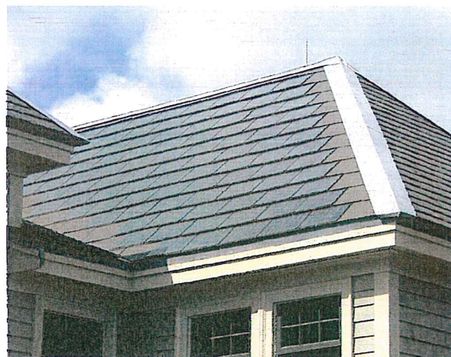
Solardachziegel aus Ton: kleine Solarzellen werden auf Tonziegel geklebt
