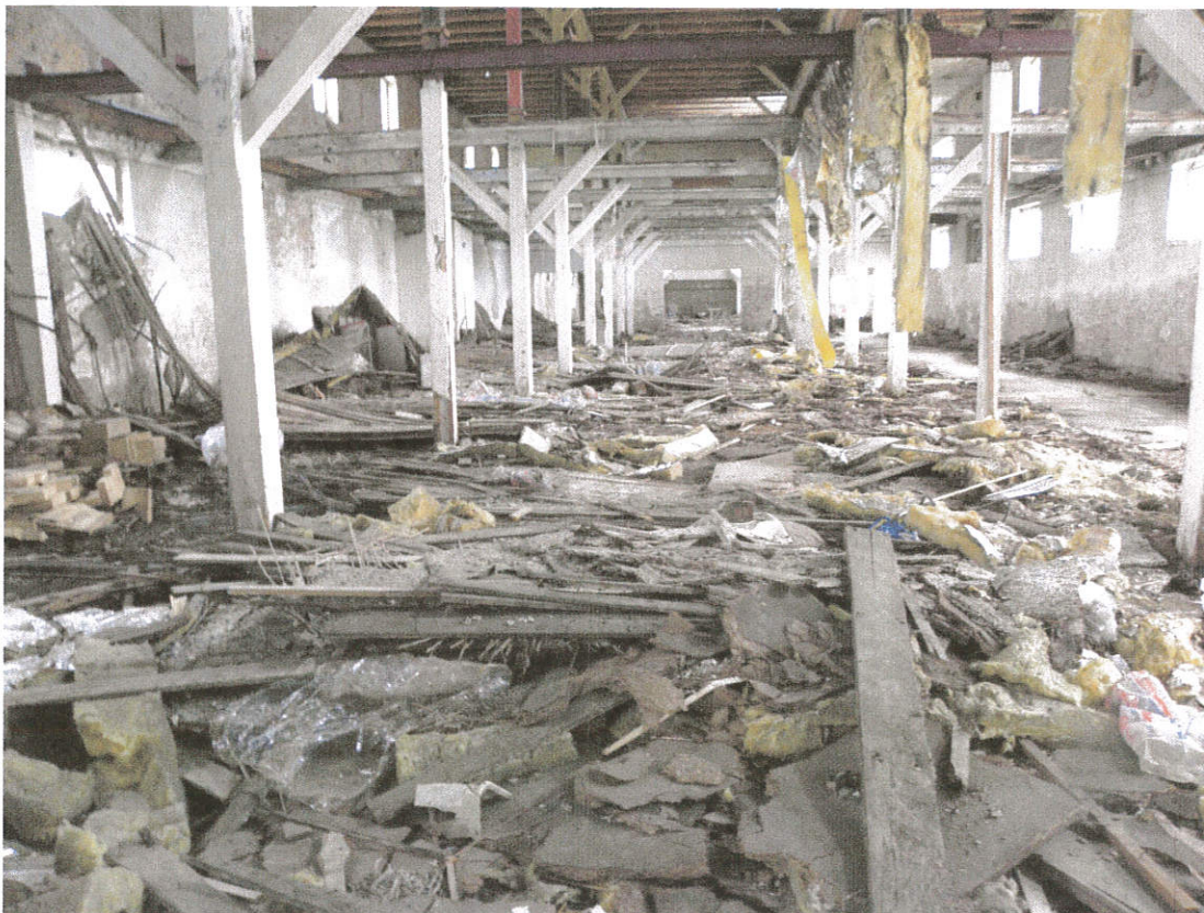
Foto 4: nicht beprobter Gebäudeteil auf Teilfläche 6 (am rechten Rand des Gebäudes wurden Proben entnommen)
