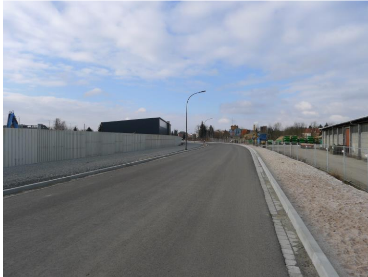
Abb. 9: Biotopklasse 12: neu errichtete B 96 innerhalb des UG
