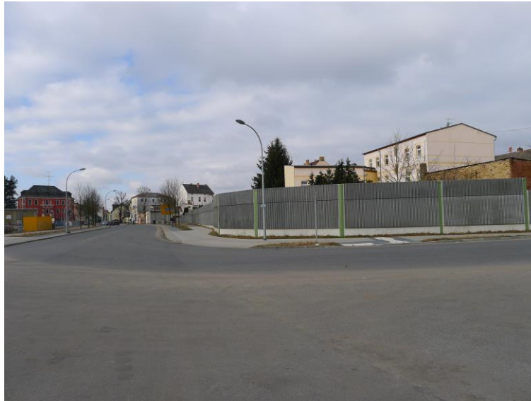
Abb. 6: Biotopklasse 12: Wohnbebauung mit Lärmschutzwand an Genossenschaftsstraße
