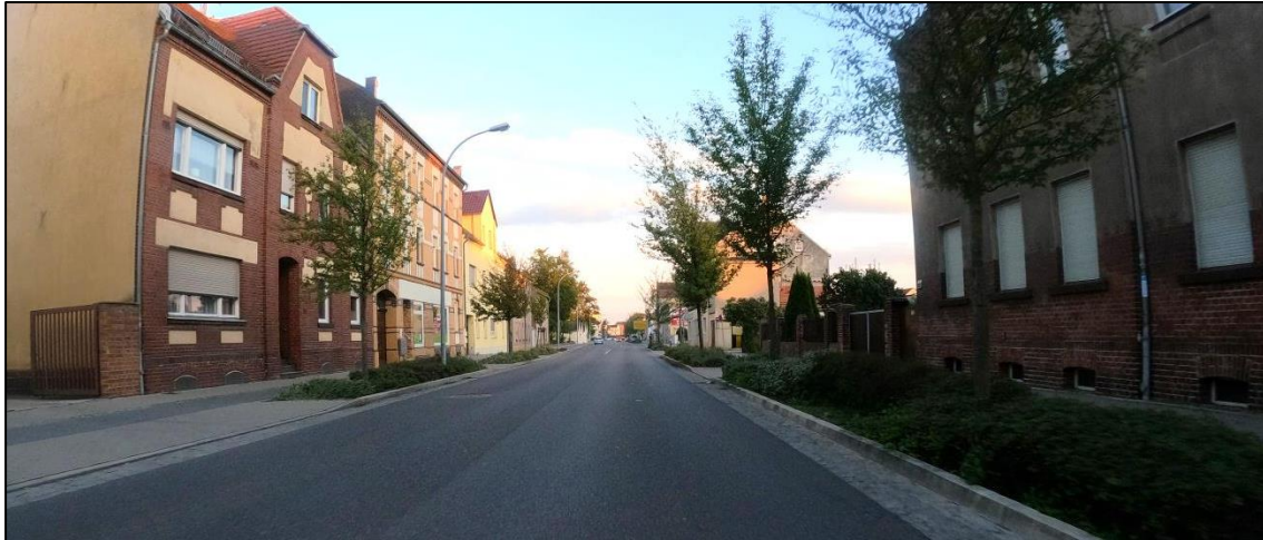
Abb. 15 Bestandssituation Sonnewalder Straße
