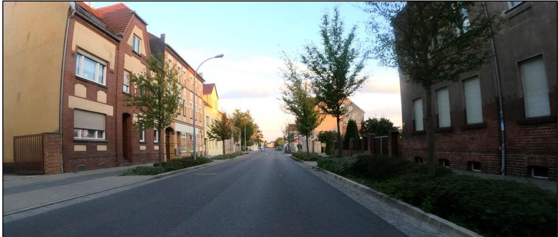
Abb. 15 Bestandssituation Sonnewalder Straße
