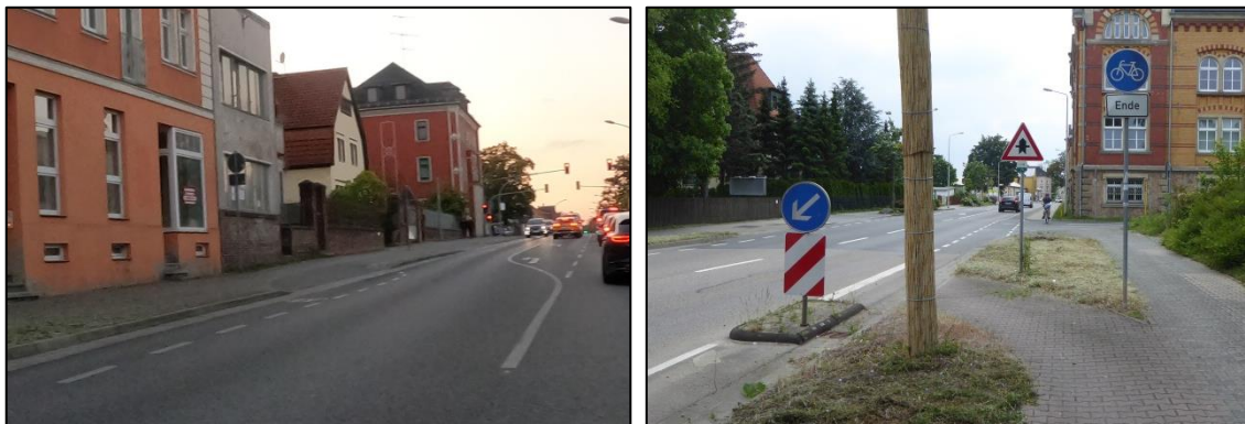
Abb. 21 Optimierungsbedarf südliches Radwegende Sonnewalder Straße
